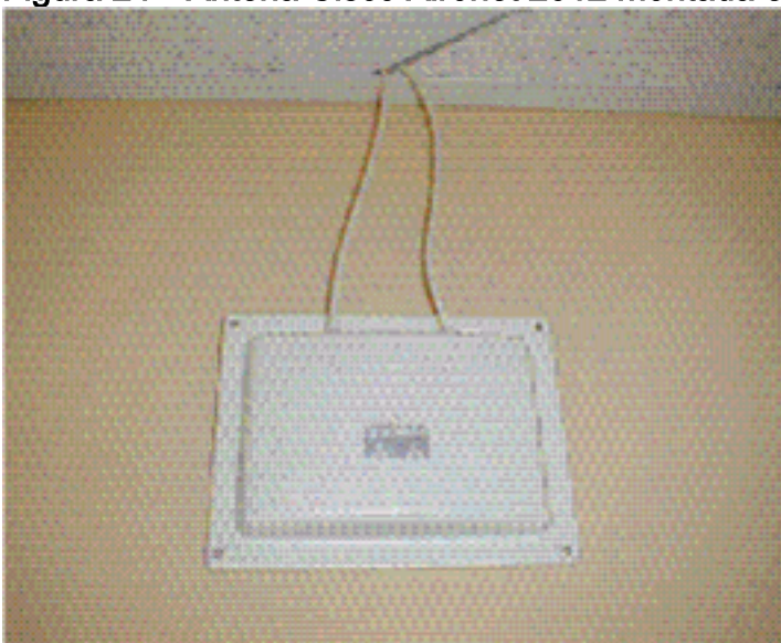
Figura 24—Antena Cisco Aironet 2012 montada em uma parede
