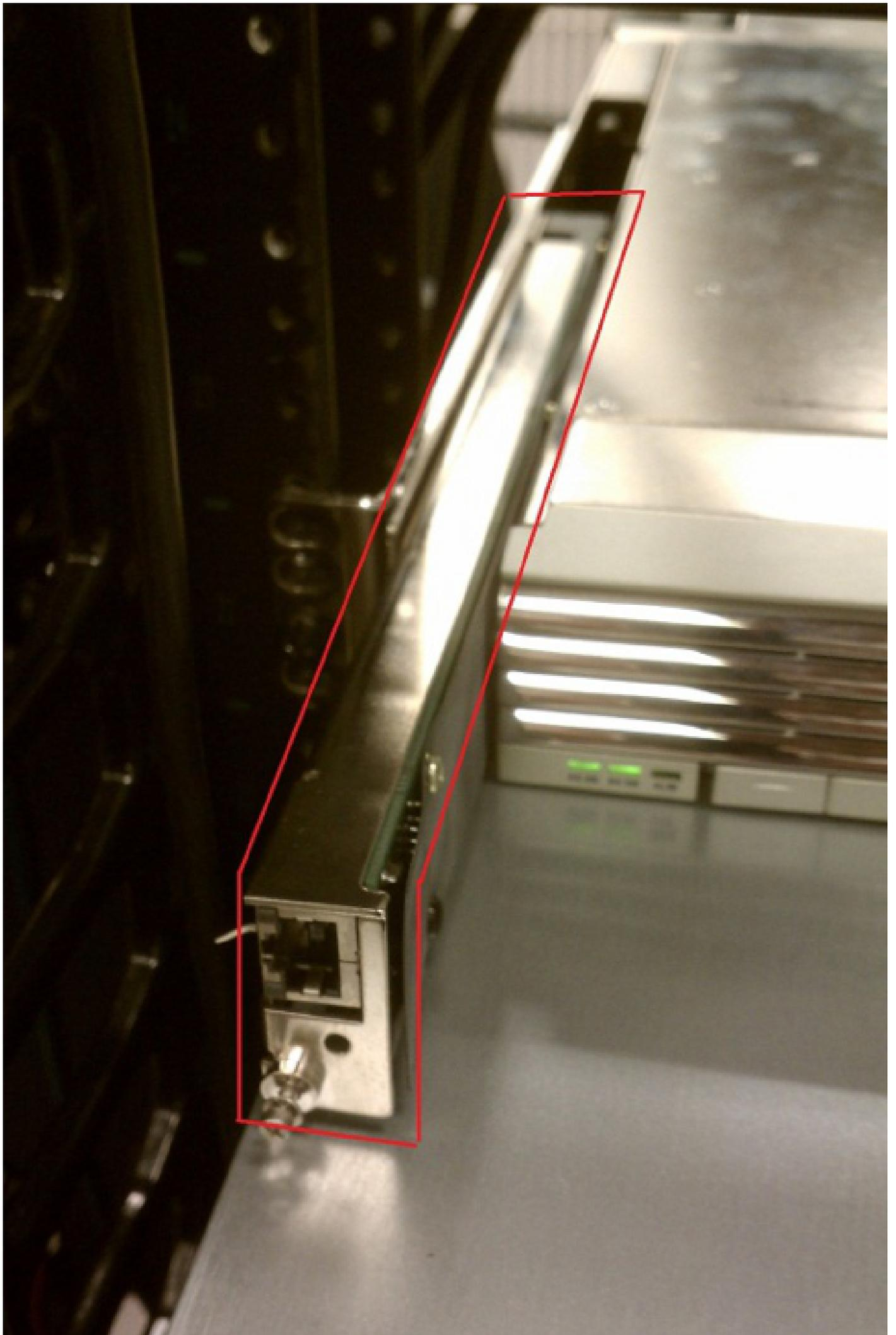
2. Si l'erreur apparaît toujours après quelques minutes, installez le redresseur dans un autre logement de l'étagère d'alimentation A ou B afin de déterminer si le problème est lié au redresseur ou au logement de l'étagère d'alimentation.
