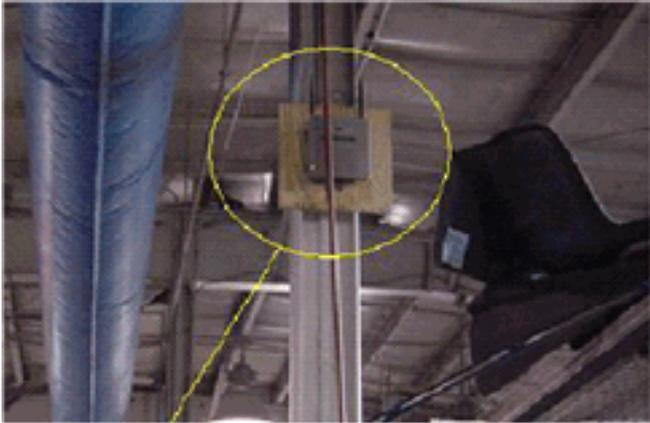
Abbildung 18 zeigt die Signalausbreitungsänderungen oder -verzerrungen, die durch einen I-Strahl verursacht werden. Der I-Strahl erzeugt viele Reflexionen sowohl von empfangenen Paketen als auch von übertragenen Paketen. Die reflektierten Signale führen aufgrund von Nullpunkten und Multipath-Interferenzen zu einer sehr schlechten Signalqualität. Die Signalstärke ist jedoch hoch, da sich die Antennen der Access Points so nahe am I-Strahl befinden.
