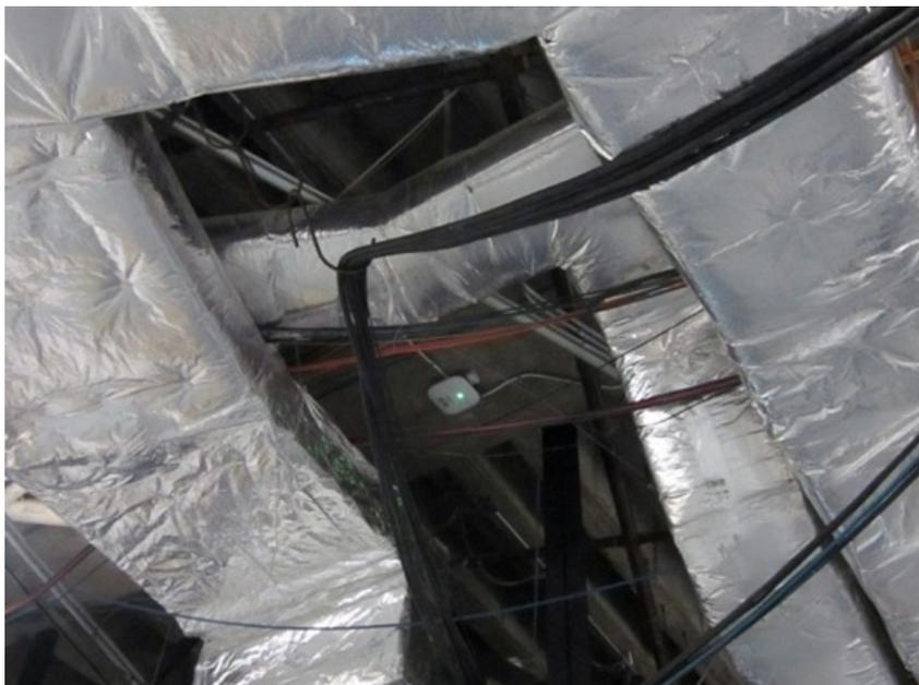
APに最適な場所ではできるだけユーザに近い場所であることに留意してください。金属や導電性を持つ物体の近くに置くことを避けてください（無線波が指向性になりヌル（デッドスポット）が増加するため）。APを高い天井に配置す
