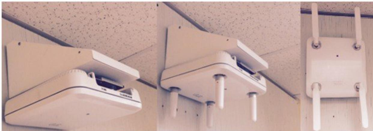
Oberon モデル 1029-00 は、「i」および「e」モデルと一緒に使用してAPを正しいアンテナの方向に向ける直角マウントです。ユニットが取り付け可能なダイポール付きの「e」モデル(右端)の場合、Oberon ウェッジマウントは必要ありません。
